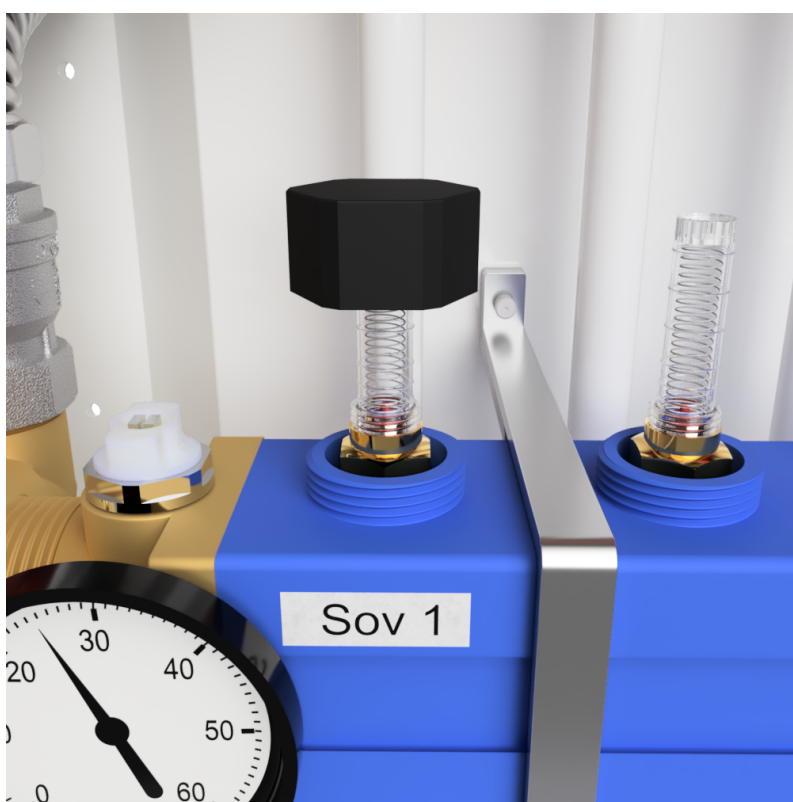
Figur 18: Justering av flowmeter med medfølgende nøkkel.
