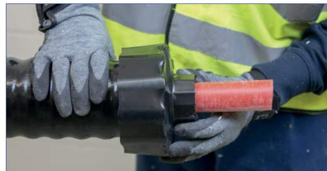
**DE** Montageablauf CALPEX Hauseinführung mit Schraubfitting
