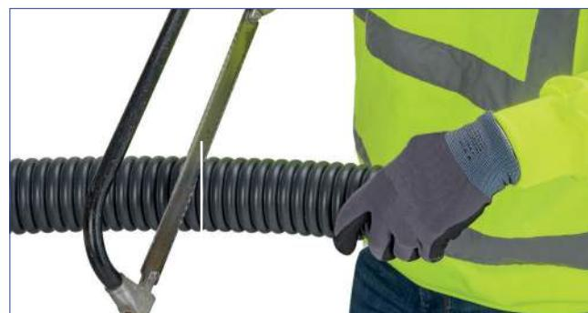
**3****EN** Open the jacket longitudinally.Cut max. **5 mm** deep into foam.**PL** Otworzyć go wzdłuż. Nacinać na maks.głębokość **5 mm** w głąb pianki**FI** Leikkaa suojuvori pituussuuntaan.Huom enintään **5 mm** leikkaussyyvyyss.**DK** Åben kappen på langs. Skær maks.**5 mm** dybt ind i skummet
